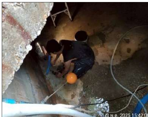
รูปภาพที่ 2.70 การล้างถังเก็บน้ำ
