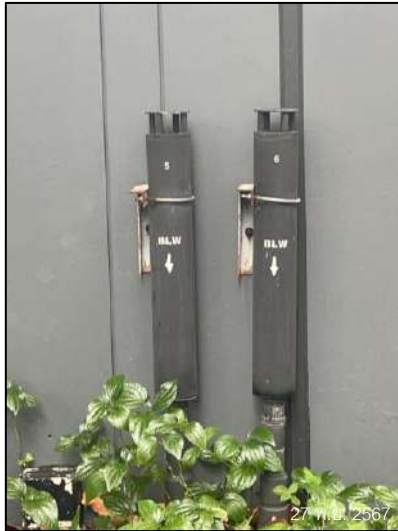
รูปภาพที่ 2.49 อุปกรณ์กำจัดก๊าซมีเทน
